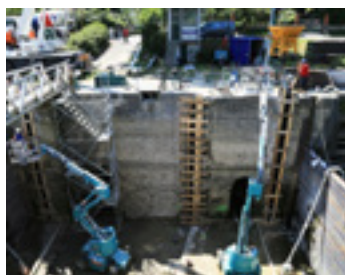
MISE À SEC DE LA TÊTE AVANT DE L'ÉCLUSE N°1 À BOUGIVAL
