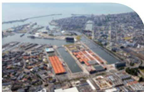
VUE AERIENNE QUARTIER SUD LE HAVRE SITE STRATÉGIQUES
