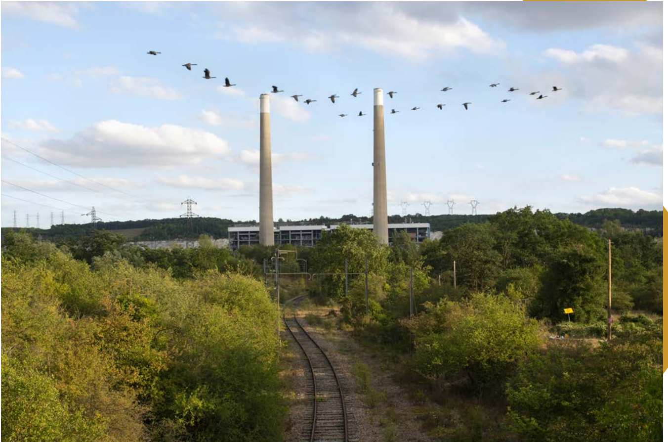
Ancienne voie ferrée desservant le centre de production thermique de Porcheville Crédit photo : © Ambroise Tézenas et Jémémie Léon. OPP de la vallée de la Seine francilien.
