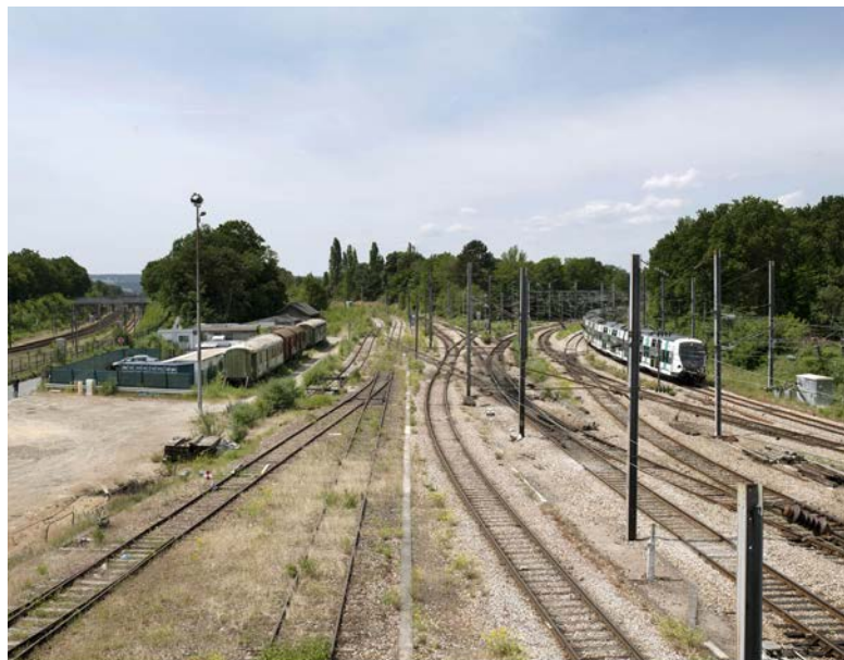
Saint-Germain-en-Laye, gare d'Achères Grand-Cormier - Crédit photo : © Ambroise Tézenas et Jémémie Léon. OPP de la vallée de la Seine francilien.
